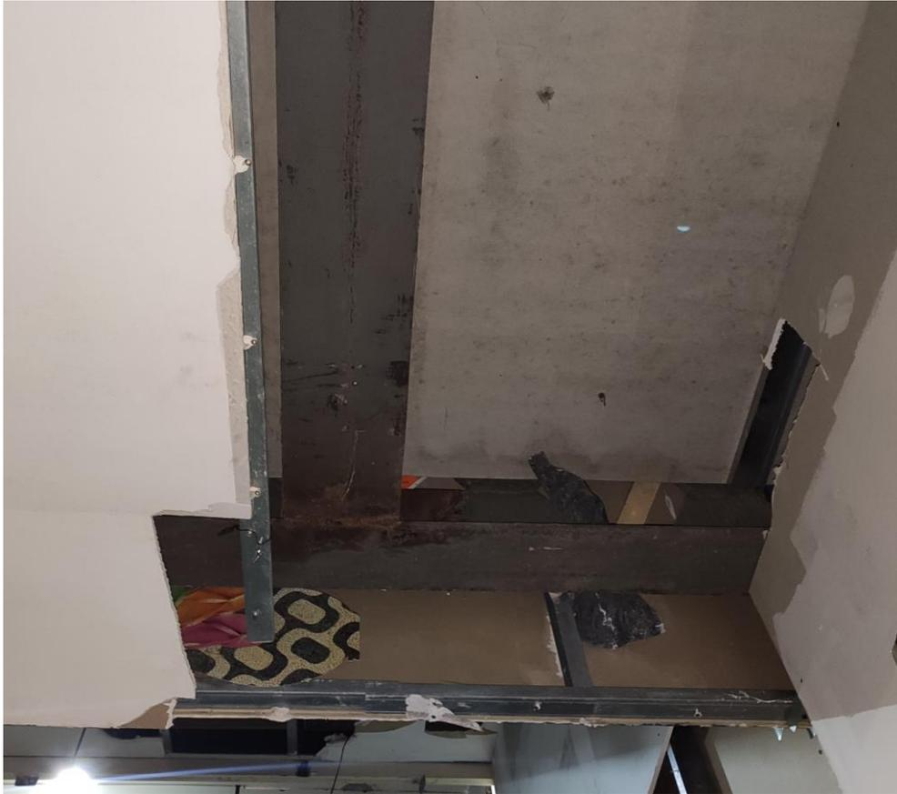
A4: Ligação Viga x Viga
