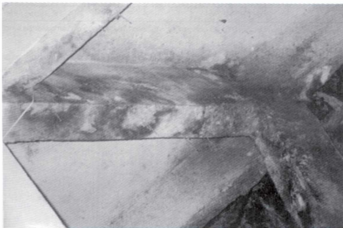
Fotografia 1.7 - Formação de estalactites no concreto
