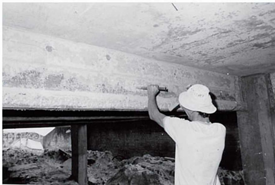
Fotografia 3.2 - Apicoamento manual da superfície de concreto
