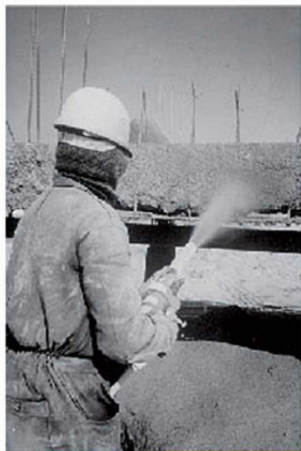
Fotografia 2.1 - Concreto projetado via úmida
