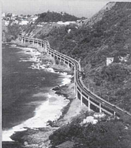
Elevado do João RJ - Recuperação e Reforço Estrutural
