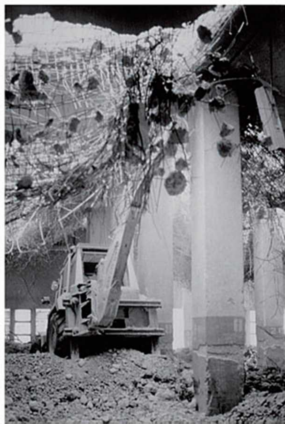
Fotografia 3.4 - Demolição de concreto
