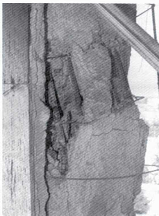
Fotografia 1.8 - Estrutura de concreto degradada pela ação de incêndio*
