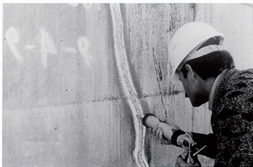
Fotografia 3.5 - Injeção de fissura
