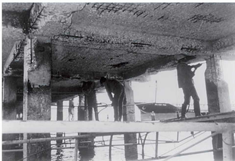
Fotografia 3.3 - Remoção de concreto por corte
